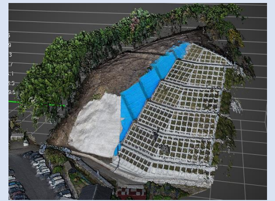
点群データ作成(伐採完了後)
