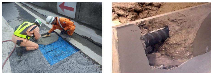
リフレモルセットSFの適用例と鉄筋裏への充填状況
