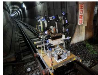
鉄道トンネル
