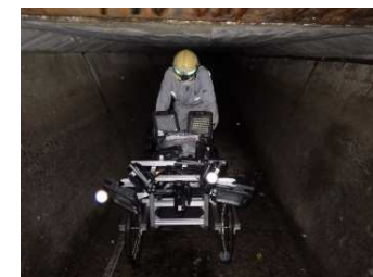
水路トンネル
