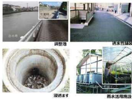
雨水貯留浸透施設の例
