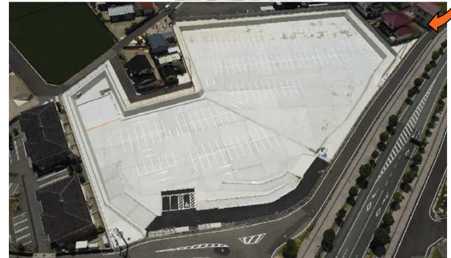
雨水貯留施設(キリリパーク) バスケットボールや臨時駐車場として利用が可能
