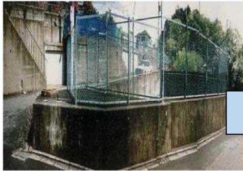
従前の防災調整池
