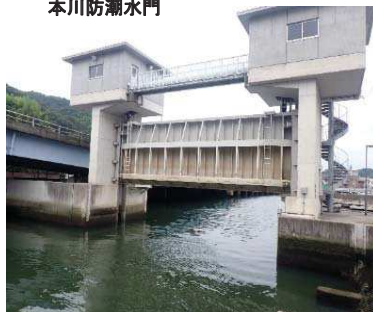
本川防潮水門
