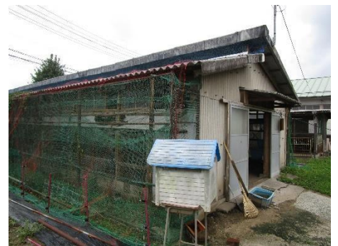
生徒が鶏舎を整備
