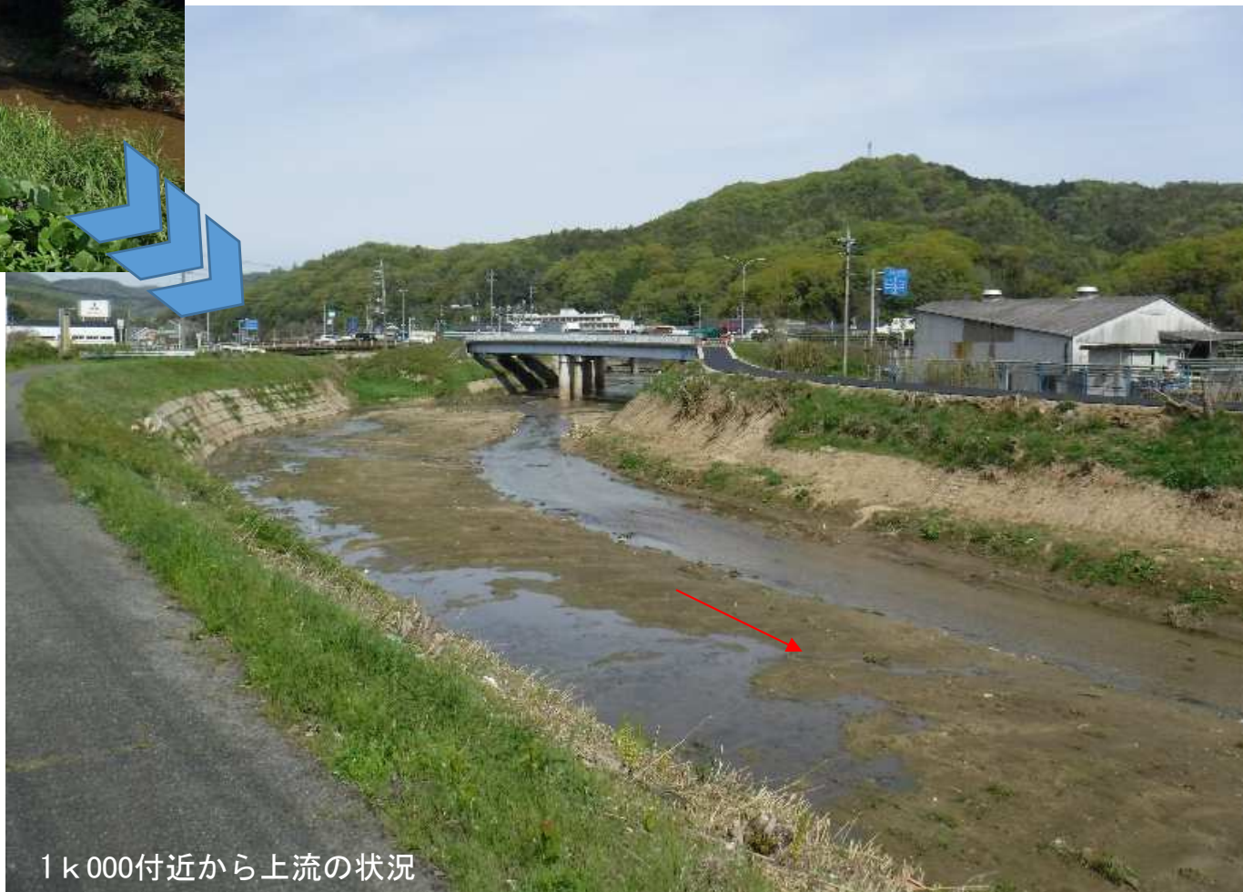
掘削工事完成 (令和3年4月撮影)
