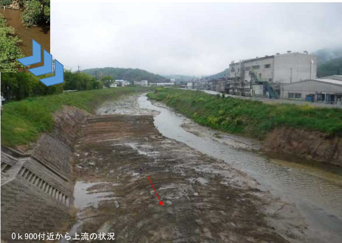
掘削工事完成 (令和3年5月撮影)
