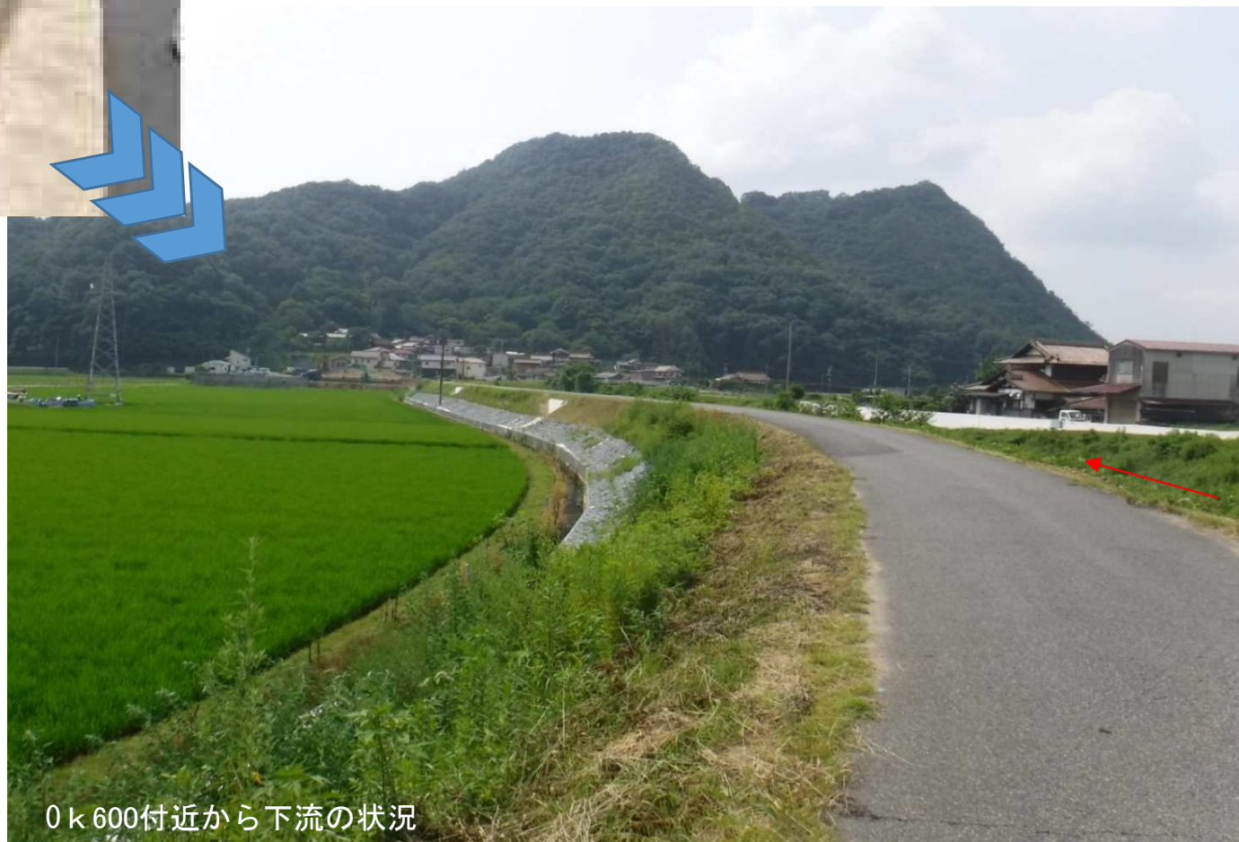
築堤工事完成 (令和4年7月撮影)
