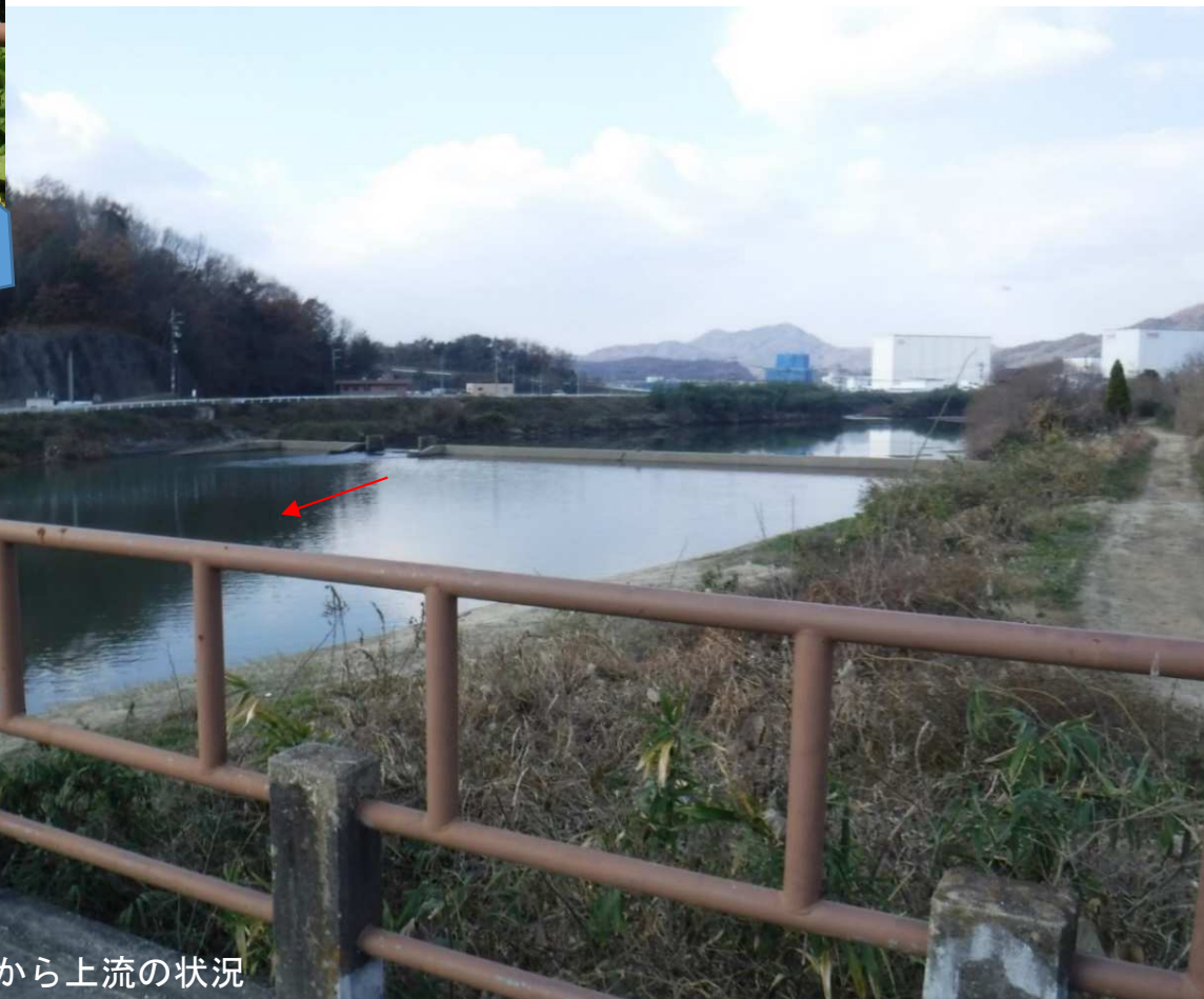
掘削工事完成 (令和2年12月撮影)
