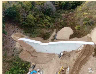
(8)2020.12 本堤工打設完了
