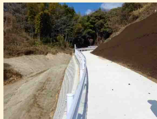
【工種】 工事完了
