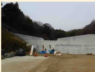
(9)2021.2 副堰堤打設状況
