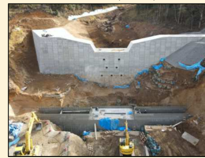
(8) 2020.12 副堰堤工(Co打設)
