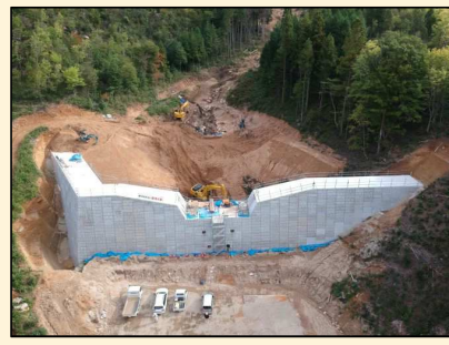
(7) 2020.9 本堤工(ソイルセメント)完了
