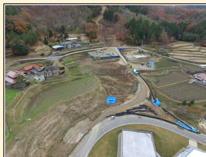
(2) 2019.11 工事用道路施工
