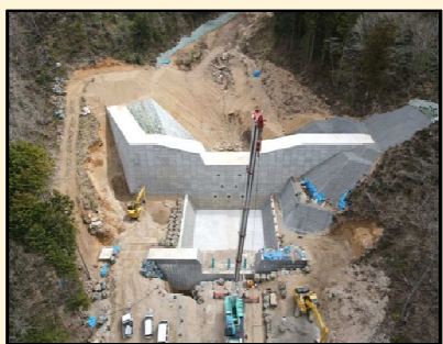
(9) 2020.4 前庭保護工(Co打設)
