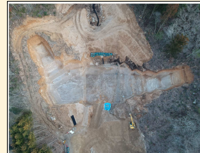
(4) 2020.2 本堤掘削完了
