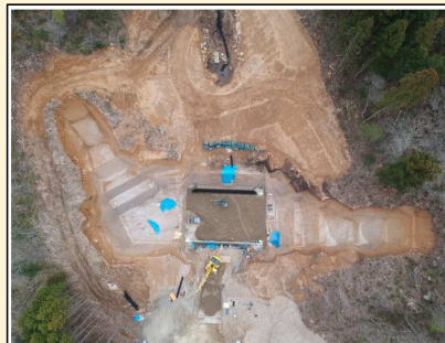
(5) 2020.3 本堤工(ソイルセメント)①
