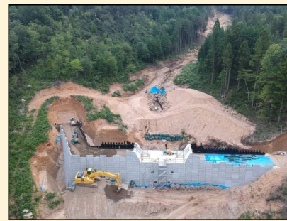
(6) 2020.8 本堤工(ソイルセメント)②
