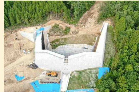
(8) 2021.6 本堤工(ソイルセメント)完了
