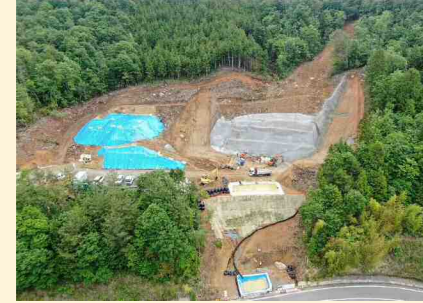
(8) 2021.6 本堤工(ソイルセメント)完了
