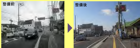
国道2号(廿日市市)歩道整備
