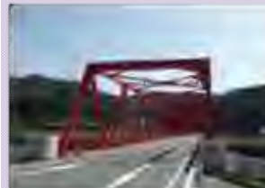
国道433号式敷大橋 修繕後
