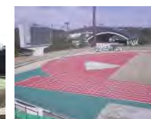
認定競技場を維持する ためのトラック更新
