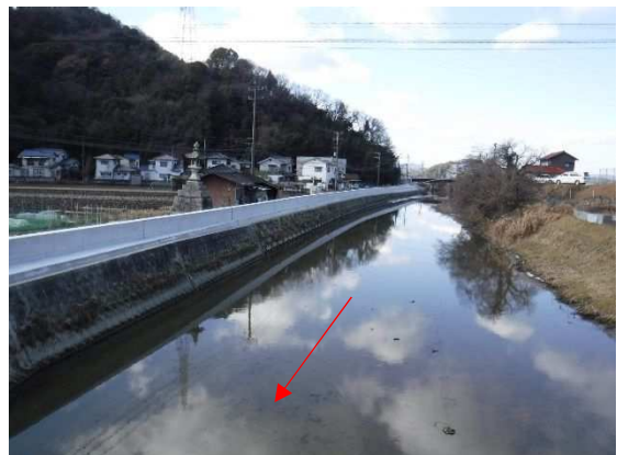
護岸の嵩上げ（天井川：三原市明神町）
