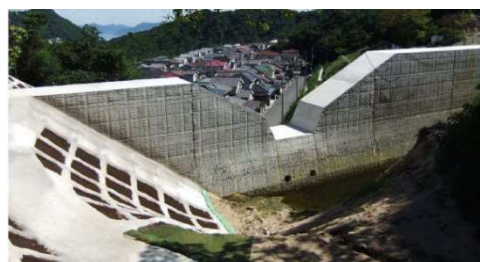
写真Ⅱ-1 砂防堰堤（安登中央川支川）
