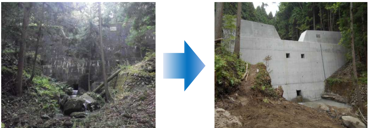
写真Ⅱ-3 砂防堰堤の改修事例（廿日市市）
