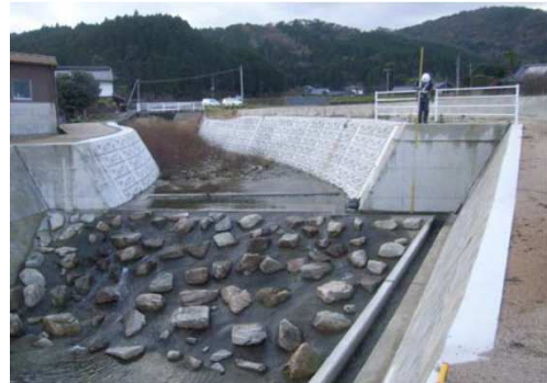
写真Ⅲ-2 護岸工及び床固工（本源寺川）
