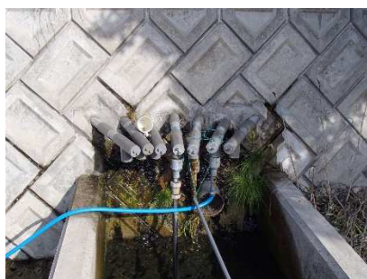
横ボーリング工
