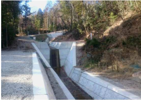
写真Ⅲ-1 護岸工及び床固工（小敷谷川）
