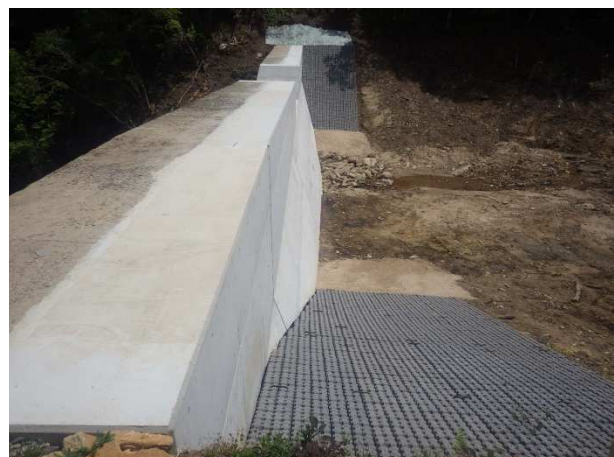
写真 I-1 砂防堰堤の修繕（矢熊川）
