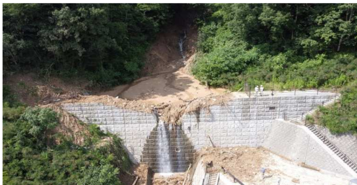
写真 I-2 UAVを用いた点検・撮影状況
