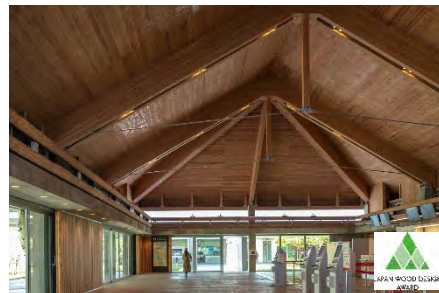
みやこ下地島空港ターミナル (沖縄県宮古島市)
