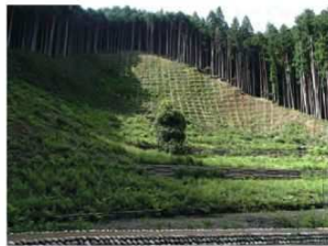
山腹工施工後9年後の様子
