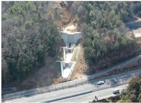
流路工 (写真下部は山陽自動車道)
