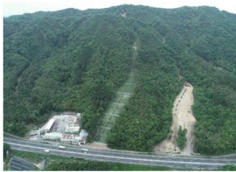
山腹工 (写真下部は山陽自動車道)
