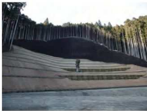
山腹工施工直後の様子
