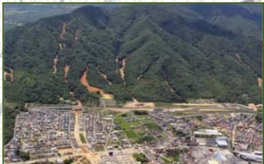
②八本松区域 (東広島市八本松町) ・ 荒廃地面積：約10ha ・ 対策工：山腹工、溪間工
