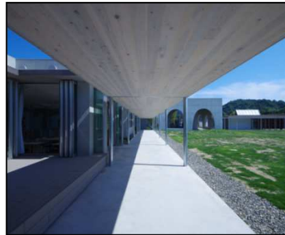
県立広島観智学園(大崎上島町) 渡り廊下の天井スラブに県産スギのCLTを使用 ※ 県施設で, CLTを初めて使用した事例
