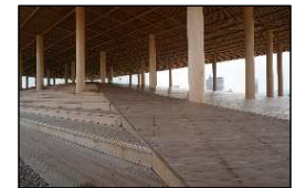
おりづるタワー屋上展望台(広島市中区) 【木材利用優良施設コンクール国土交通大臣賞】
