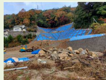
(7) 2019.11 法面工(吹付法砕工)状況
