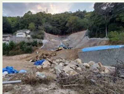
(6) 2019.10 法面工(ラス張工)状況
