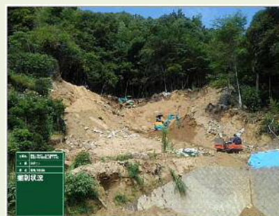
(7) 2019.11 法面工(吹付法砕工)状況
