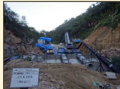
(6) 2020.9 本堤工(コンクリート)①
