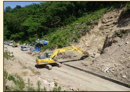
(3) 2020.6 本堤掘削状況②
