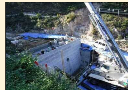
(7) 2020.10 本堤工(コンクリート)②
