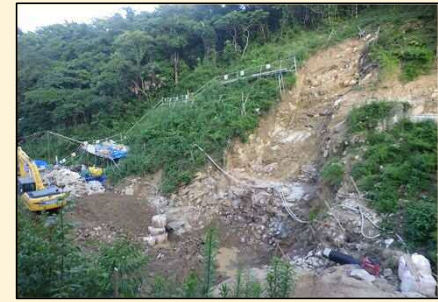
(4) 2020.7 本堤掘削状況③
