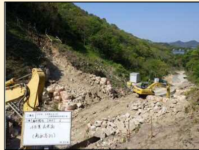
(2) 2020.4 本堤掘削状況①
