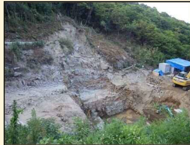
(5) 2020.8 本堤掘削完了
