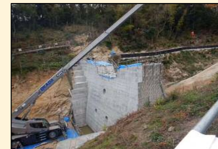
(8) 2020.12 本堤工(コンクリート)③
