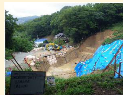
(4)2019.8 本堤掘削完了
