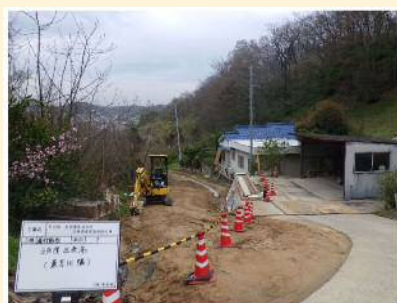
(9)2020.3 取付水路施工状況①
