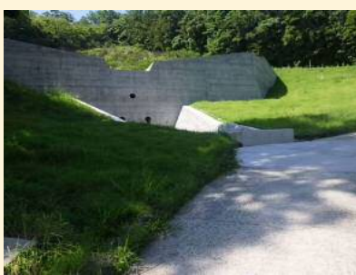
(11)2020.7 堰堤付属物設置工
