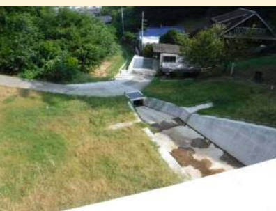
(10)2020.5 取付水路施工完了
