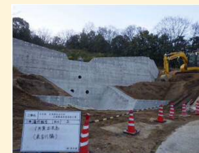
(8)2020.1 前庭保護工完了
