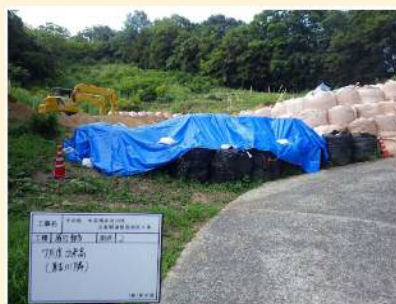
(2)2019.7 本堤掘削状況①
