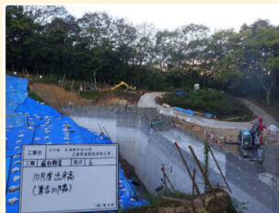
(6)2019.10 本堤工(コンクリート)②
