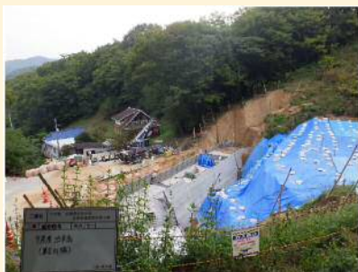
(5)2019.9 本堤工(コンクリート)①
