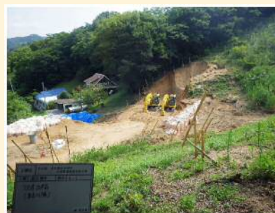
(3)2019.7 本堤掘削状況②
