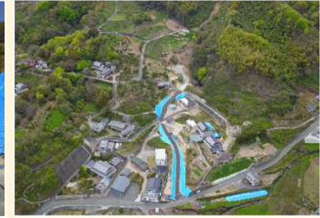
(4)2020.4 工事用道路完成
