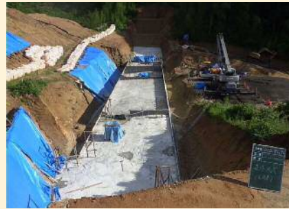
(6)2020.6 本堤工(コンクリート)①
