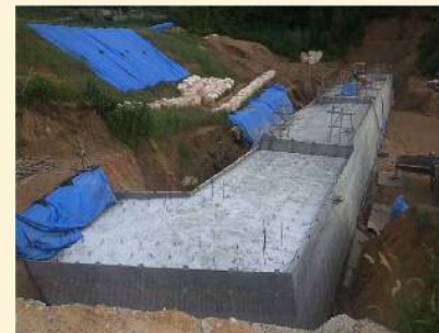
(7)2020.7 本堤工(コンクリート)②
