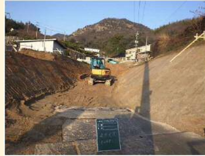
(2)2020.2 工事用道路施工①
