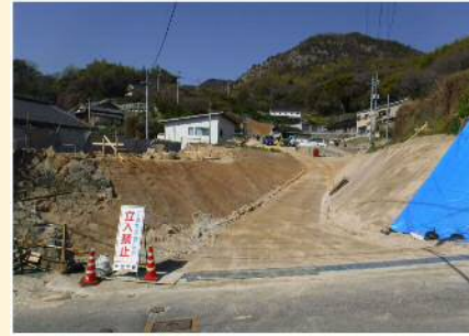
(3)2020.3 工事用道路施工②
