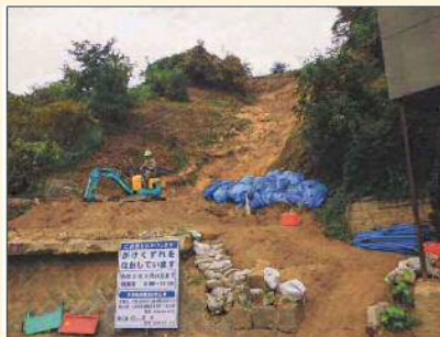
(6)2020.6 鉄筋挿入完了
