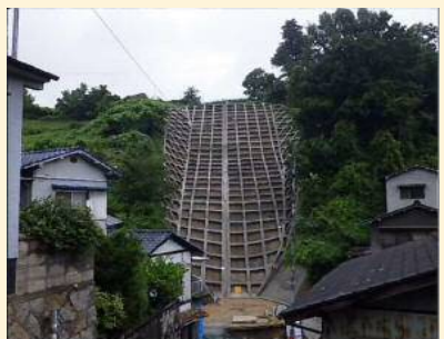
(6)2020.6 鉄筋挿入完了
