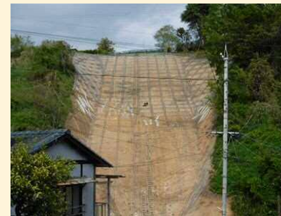
(4)2020.4 法枠鉄筋設置工
