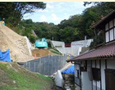
(11)2020.10 管理用道路工
