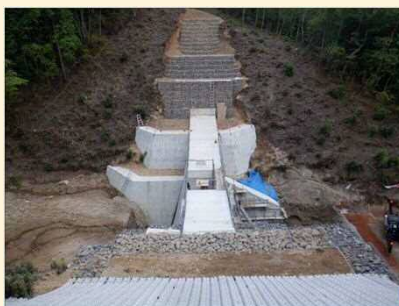
(9)2020.7 仕戻し工完了
