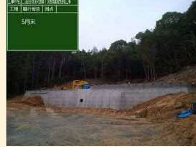
(6)2020.5 本堤打設状況②
