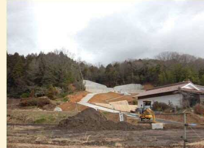
(11)2021.2 管理用道路工
