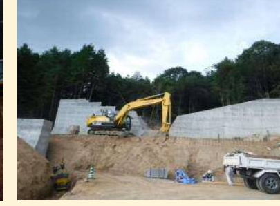
(8)2020.8 本堤打設状況④
