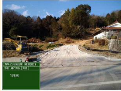
(2)2020.1 工事用道路完了
