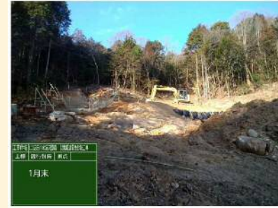
(3)2020.1 本堤掘削状況
