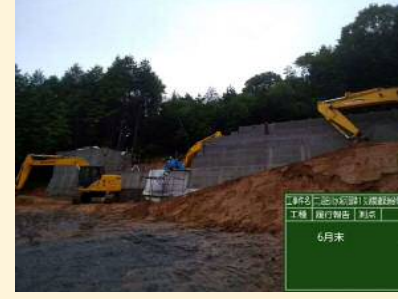
(7)2020.6 本堤打設状況③
