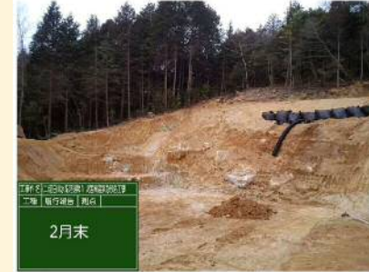
(4)2020.2 本堤掘削完了
