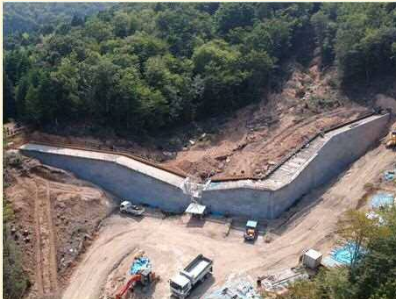
(9) 2020.8 本堤工(ソイルセメント)④
