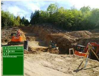
(5) 2020.4 本堤掘削②
