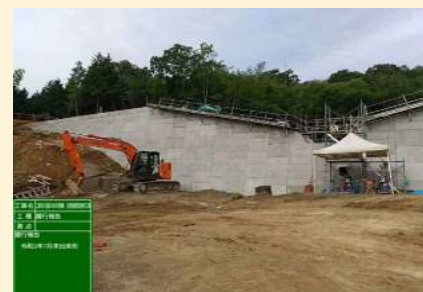
(8) 2020.7 本堤工(ソイルセメント)③
