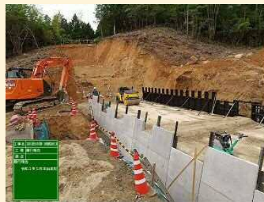
(6) 2020.5 本堤工(ソイルセメント)
