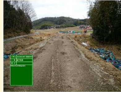
(3) 2020.2 工事用道路施工②
