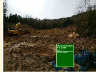
(4) 2020.3 本堤掘削①
