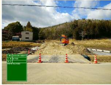
(2) 2020.1 工事用道路施工①
