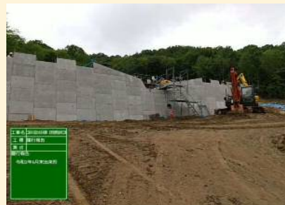
(7) 2020.6 本堤工(ソイルセメント)②
