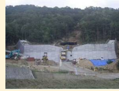
(8)2020.8 本堤工(ソイルセメント)完了
