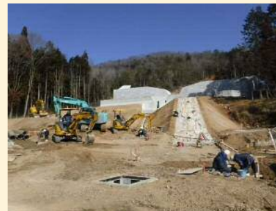
(11)2021.2 管理用道路工
