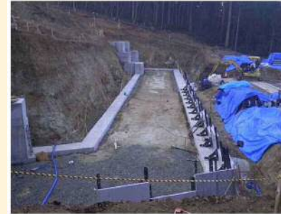
(8)2020.8 本堤工(ソイルセメント)完了
