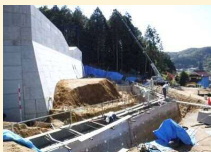
(9)2020.10 副堤工打設状況
