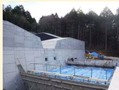
(10)2020.12 側壁Co打設
