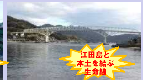
(国)487号 早瀬大橋(呉市~江田島市)
