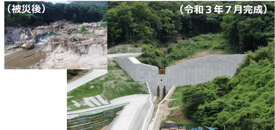
【東両谷川 砂防激甚災害対策特別緊急事業 (呉市)】
