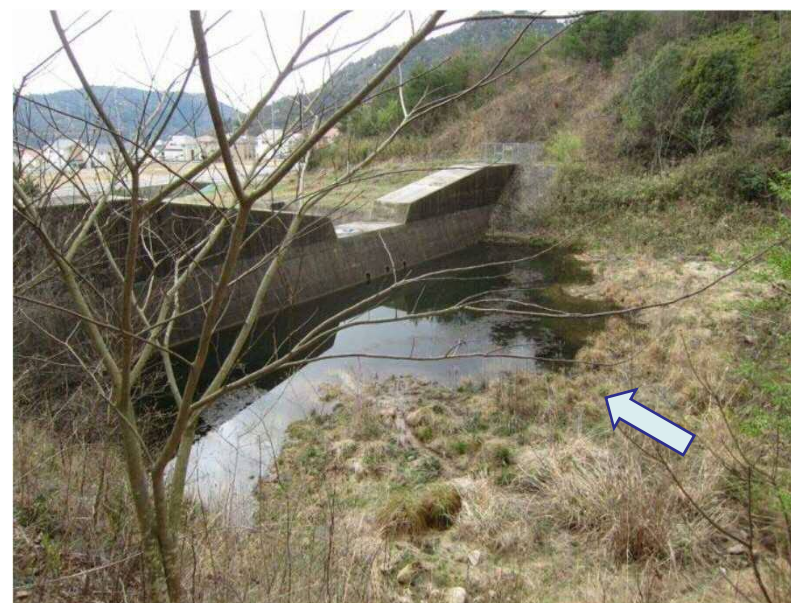
土石流発生前 の状況 (H28.10)
