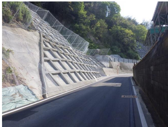
主要地方道呉環状線 呉市警固屋
