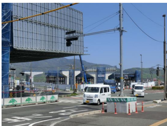
東広島呉道 阿賀IC (建設が進む立体化工事)
