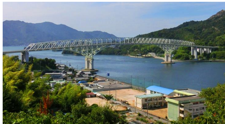
一般国道487号 早瀬大橋
