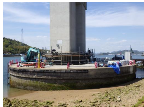
耐震補強施工状況（P 3 橋脚）
