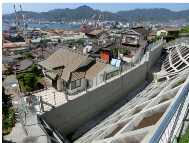
急傾斜地崩壊対策事業 宮原八丁目
