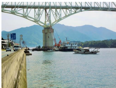
耐震補強施工状況（P 3 橋脚）
