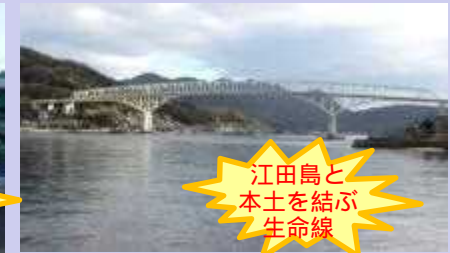
(国)487号 早瀬大橋(呉市~江田島市)
