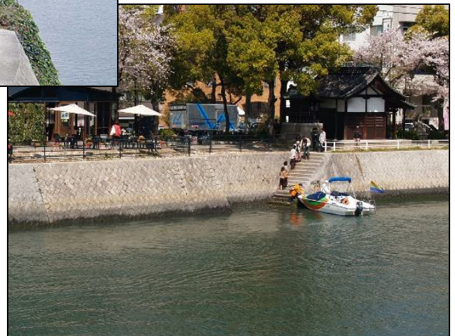
■ 既存の階段護岸を利用した水上タクシー（京橋川：広島市）
