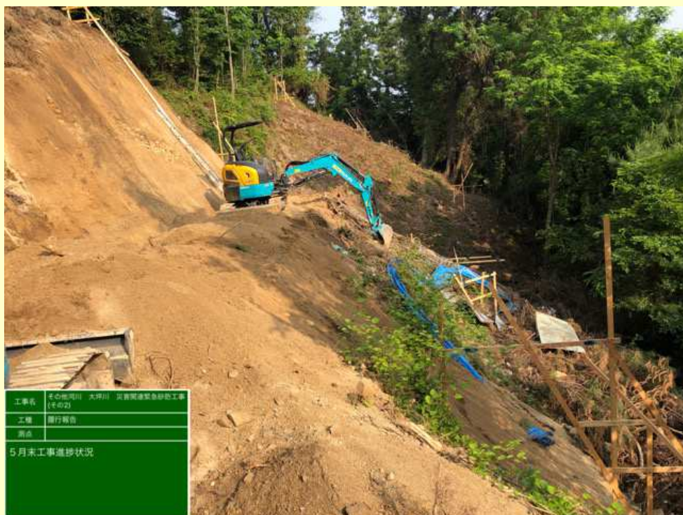
工事用道路工 (R2.5月末時点)
