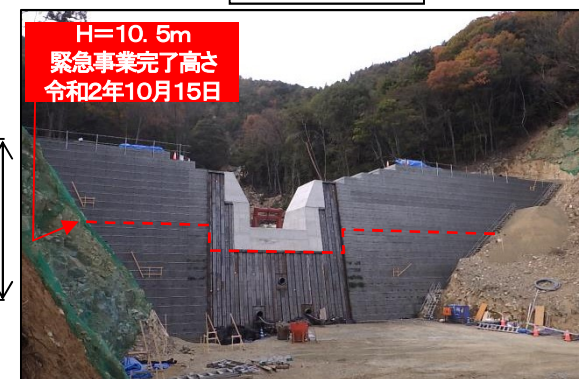
工事完了（令和2年12月15日）
