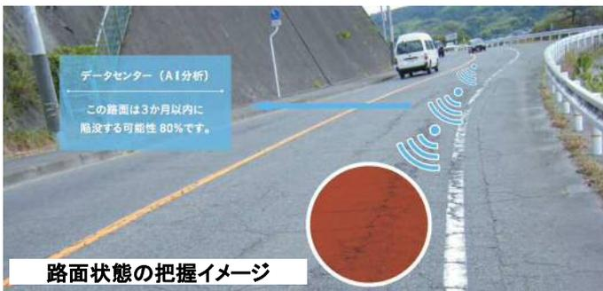
◀舗装は、週1回の道路巡視や5年に1回の路面性状調査(ひび割れ率、わだち掘れ、平坦性)を実施しています。本県が管理する道路延長は、約4,200kmと膨大な施設規模であるため、従来の調査手法にとられない、効率的かつ低廉な調査手法が必要となっています。
