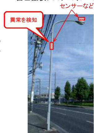
▲道路照明の点検において、支柱埋込部の腐食は外観からの目視で確認できず、掘削調査等が必要となるため、より効率的な点検手法が求められています。
