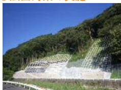
法面災害防除工事例 (法枠工事)
