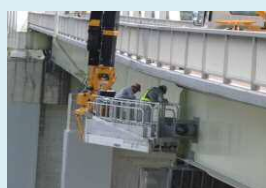
橋梁の点検状況
