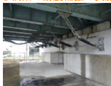
橋梁耐震工事例 (落橋防止)
