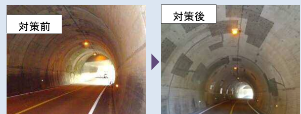
剥落防止シート設置
