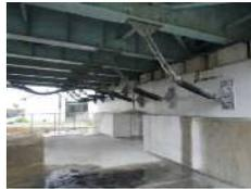
橋梁耐震工事例 (落橋防止)
