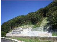
法面災害防除工事例 (法枠工等)
