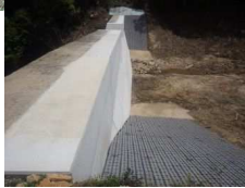
写真-1 砂防堰堤の修繕事例（三原市）
