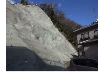
施工後 (繊維補強モルタル吹付後)
