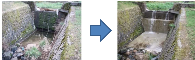
写真-3 施設の修繕例 (床固工)
