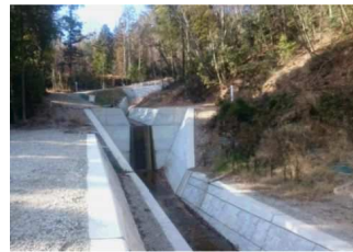
写真-1 護岸工および床固工
