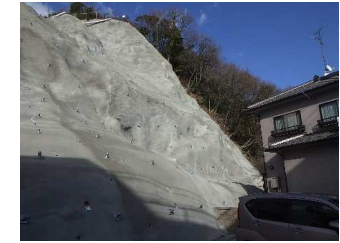
施工後 (繊維補強モルタル吹付後)
