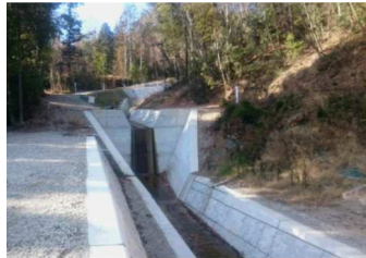
写真-1 護岸工および床固工
