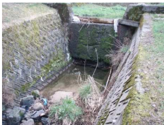
写真-3 施設の修繕例 (床固工)
