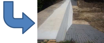
写真-1 砂防堰堤の修繕事例（三原市）
