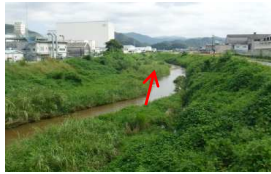
河道掘削時には滞筋の確保を図る
