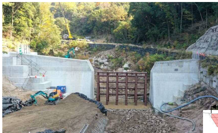
工事完了(令和2年11月20日)
