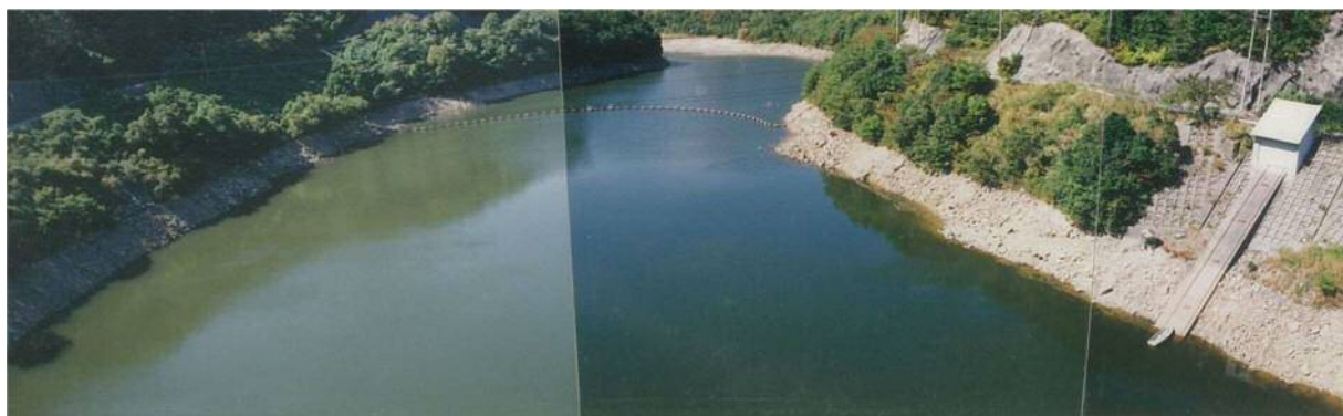
野呂川ダム貯水池状況(平成6年9月26日 : E.L. 119.84m)
