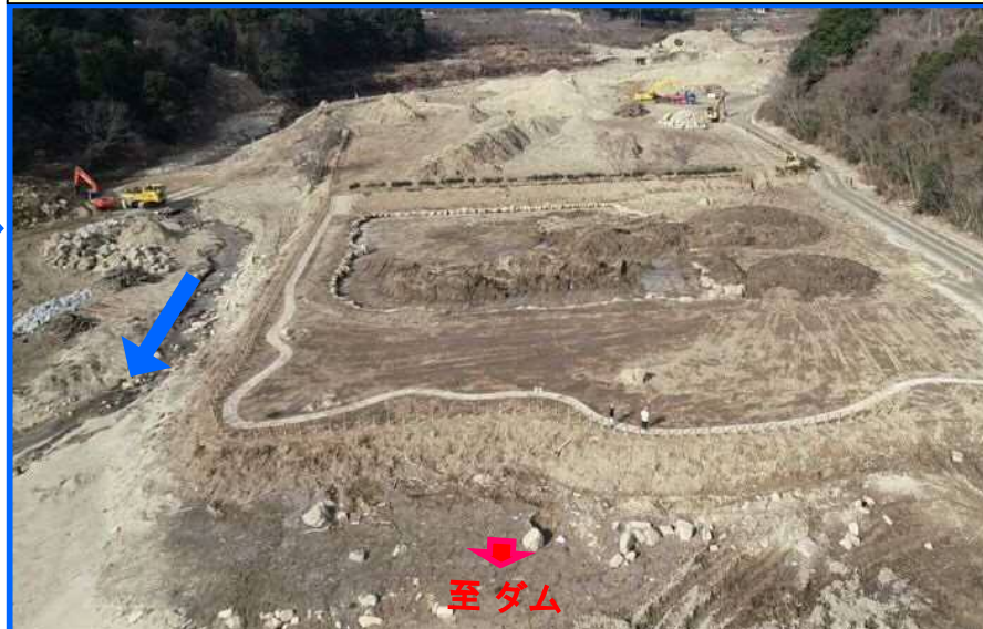
堆積した土砂の撤去工事状況（平成31年2月18日）
