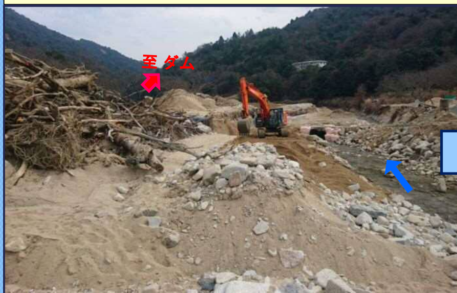
土砂撤去工事着手前（平成31年1月15日）
