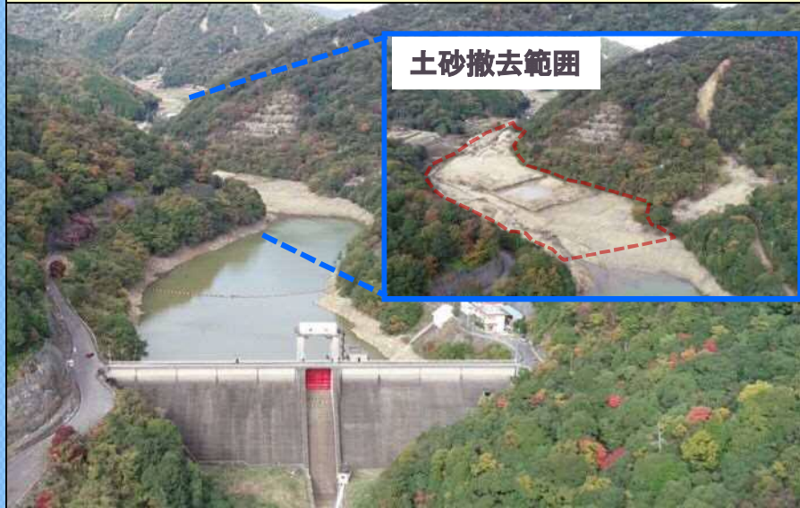
土石流等からの土砂によりダム貯水池内に土砂が堆積
