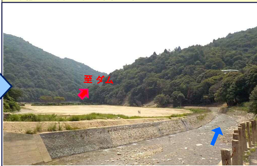
土砂撤去工事完了後（令和元年7月17日）
