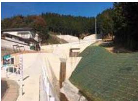
根谷川支川 101 溪流保全工
