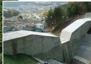
根谷川支川 101 砂防堰堤
