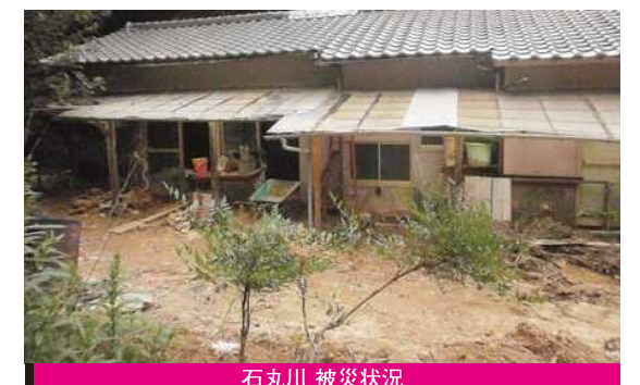
石丸川 被災状況
