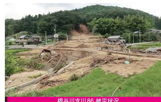
根谷川支川86 被災状況
