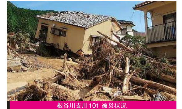
根谷川支川101 被災状況
