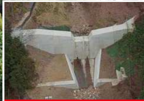
谷尻川 (上流) 砂防堰堤
