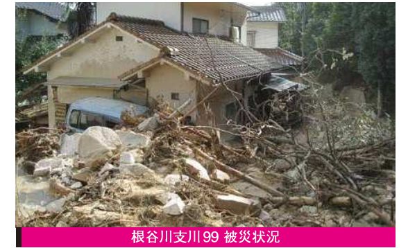
根谷川支川99 被災状況
