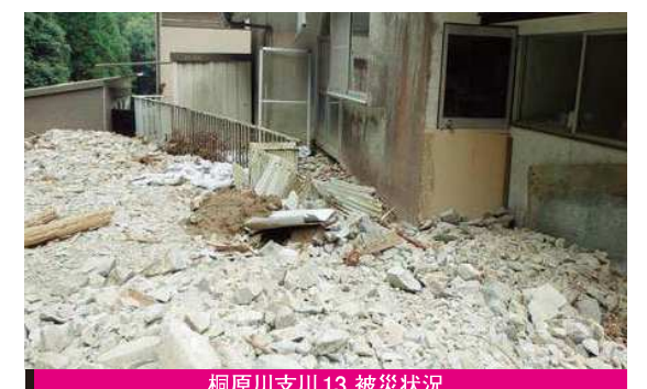
桐原川支川13 被災状況
