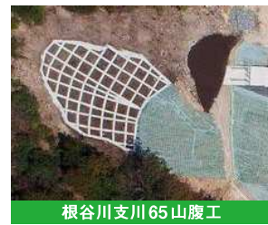
根谷川支川 65 山腹工
