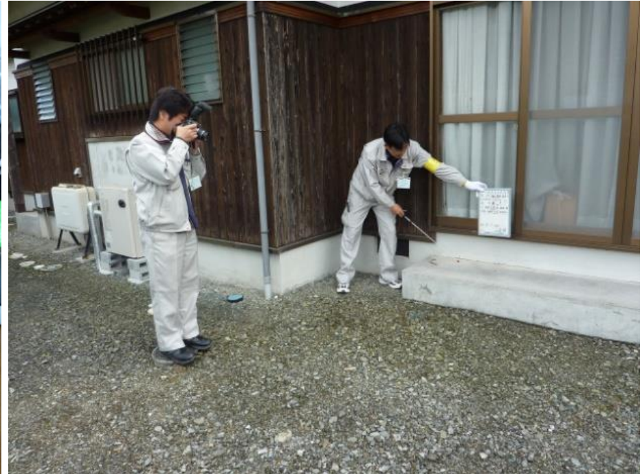
建物の外壁、基礎等の 損傷状況の調査
