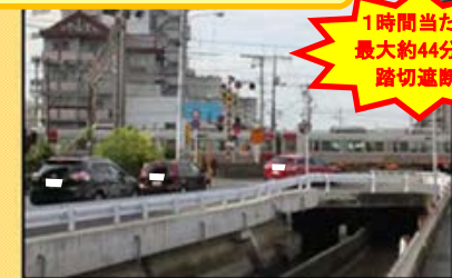
新町踏切(海田町) (開かずの踏切)
