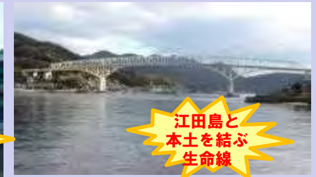
(国)487号 早瀬大橋(呉市~江田島市)
