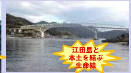
(国)487号 早瀬大橋(呉市~江田島市)
