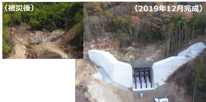
【二河川支川 災害関連緊急砂防事業 (熊野町)】
